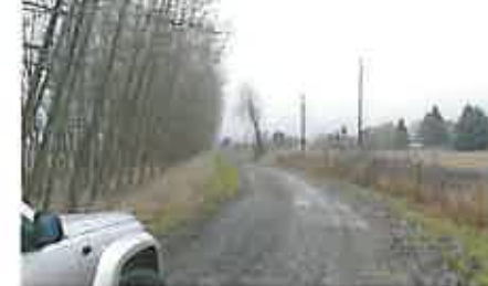
(D) Access Road and Poplar Screen
