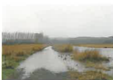
(D) Flooded Access Road
